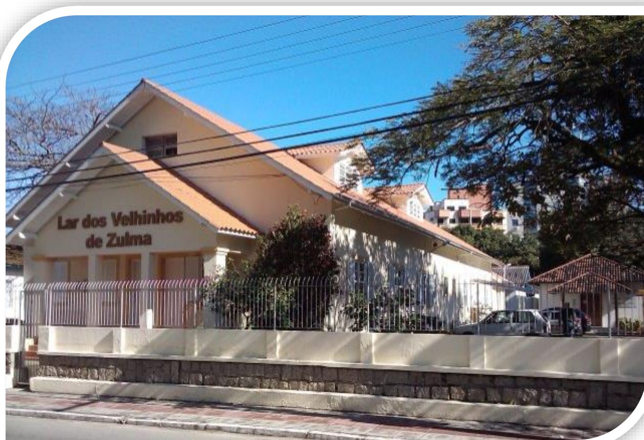
Fachada frontal do Lar dos Velinhos de Zulma
